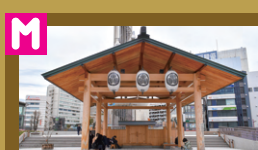
M 水戸駅北口 ペDESTリアンデッキ
